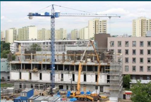
Przykład dynamicznego rozwoju. Budowa jednego z Centrów Danych F4
